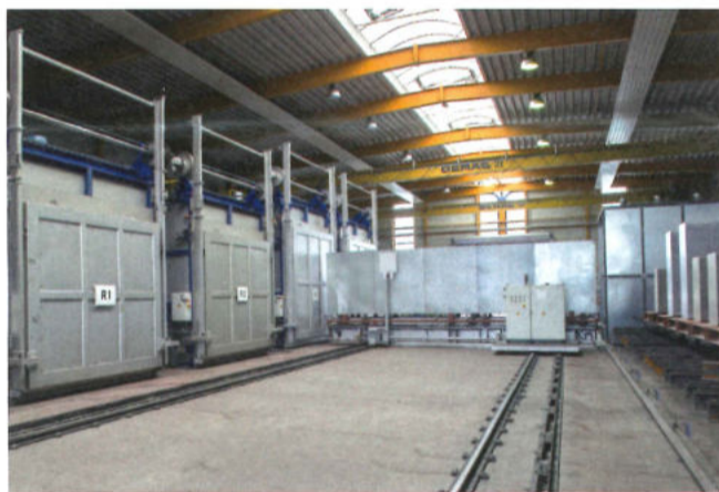
Vollautomatische Wärmebehandlungsanlage bei Gleich
